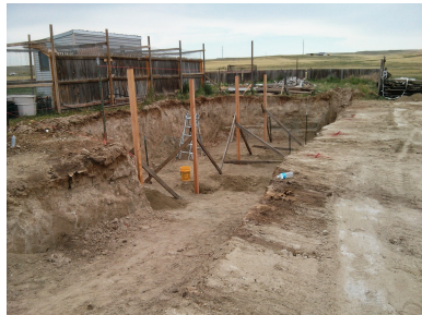
Set the 12' 4x4 posts. 3' in the ground 9' above 12 '4x4 게시물을 설정하십시오. 지상 9 '위 3'
