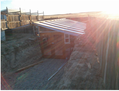
Added another 2x4 to the top of the tarp to hold in place 방수포 상단에 다른 2x4를 추가하여 고정
